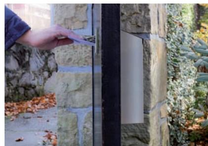
La correspondencia se introduce por el bocacartas desde el exterior de la puerta y se recoge en el interior mediante el recogecartas. >
