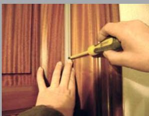
En primer lugar, colocaremos los dos perfiles cuadrados atornillados a 4mm del comienzo de la puerta. Podemos ayudarnos de cualquier tipo de madera o soporte de ese espesor. Para marcarlos y posteriormente atornillarlos, cabe recordar la necesidad de separarlos del suelo hasta alinearlos con el nivel inferior de la puerta.
