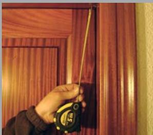
Para colocar los ángulos antihurto, lo primero que tenemos que hacer será medir la altura del marco. Compraremos los ángulos que se adapten a esa medida (2,1 m. o 2,5 m.) y cortaremos los perfiles. Los dos perfiles en L se deben cortar de la misma medida que la altura del marco para que se adapten completamente. Los dos perfiles cuadrados, los cortaremos de tal manera que queden alineados a la parte inferior de la puerta y que sobren 2 o 3 mm. en la parte superior.
